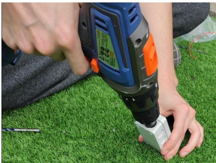
Figura 44. Furo na caixa estanque para instalação da câmara.
